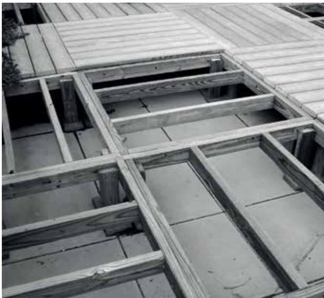
Um sistema de dormente é um intermediário entre uma superfície sólida e o deck Trex®. Drenagem, acesso e fluxo de ar são críticos. A água precisa fluir e passar pelo deck. Para reparos e remoção de detritos, é necessário acessar o sistema de travessas. Um bom fluxo de ar manterá o deck seco e em boas condições.
